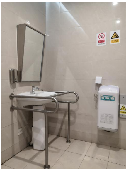
图 13 左图：新修无障碍厕所洗手台（镜子有倾斜处理）图 14 右图：老旧无障碍厕所洗手台
