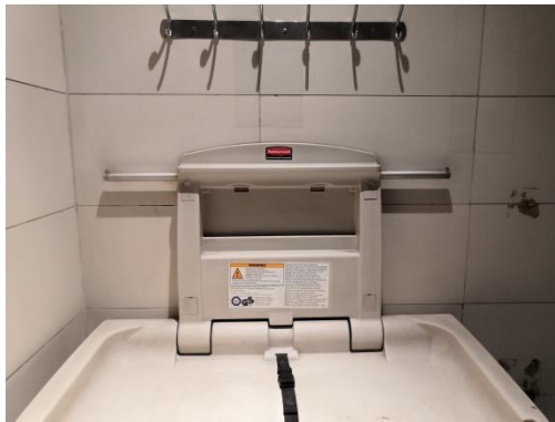
图 10 老旧无障碍厕所内部设施齐全 上图为母婴台和挂钩
