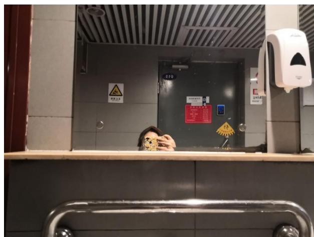
图9 老旧站台无障碍厕所洗手台的镜子没有做倾斜处理
