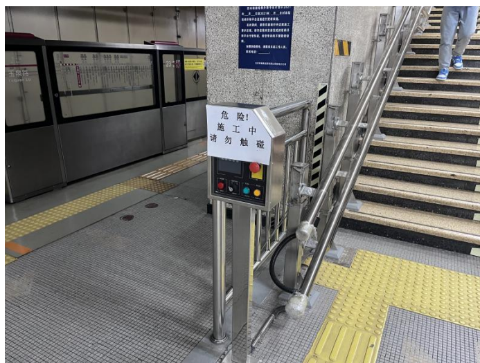
图 15 施工中的爬楼机
